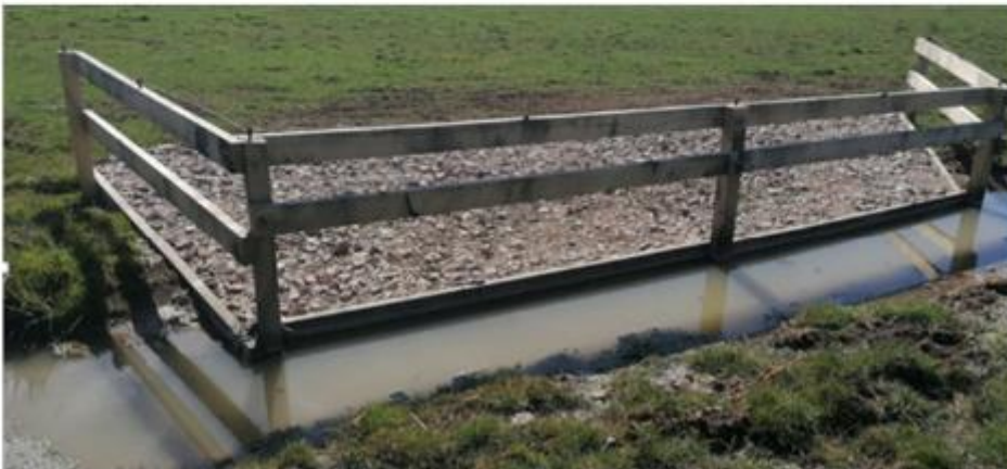
Photo 2: Aménagement d'abreuvement au fil de l'eau sur le ruisseau du Pont Allard
